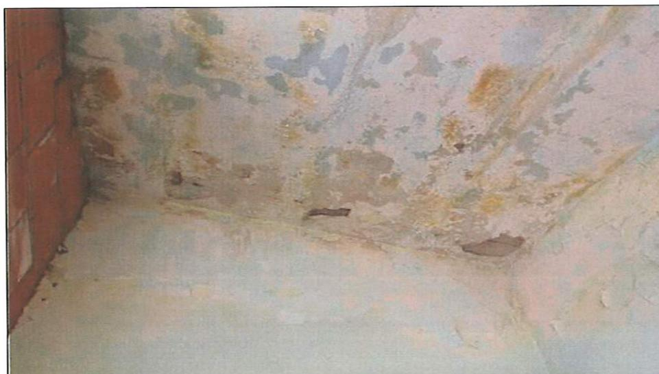
foto 16 - vista del soffitto della camera n. 2 con le infiltrazioni di acqua provenienti dalla copertura.
