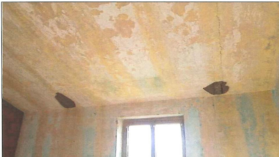
foto 12 - vista del soffitto con le evidenti infiltrazioni di acqua come sopra.
